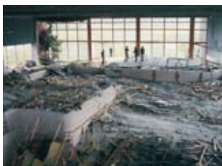
В 1985 подвесное бетонное перекрытие закрытого бассейна обрушилось в г. Устер, Швейцария. Хотя не было видно никаких внешних дефектов в потолочных креплениях из нержавеющей стали, внутри они были полностью разрушены в отдельных местах из-за коррозионного растрескивания под нагрузкой.
