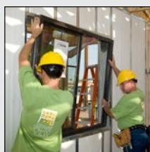
Крепление оконных рам к различным видам оснований
