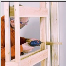
Крепление направляющих для лёгких конструкций
