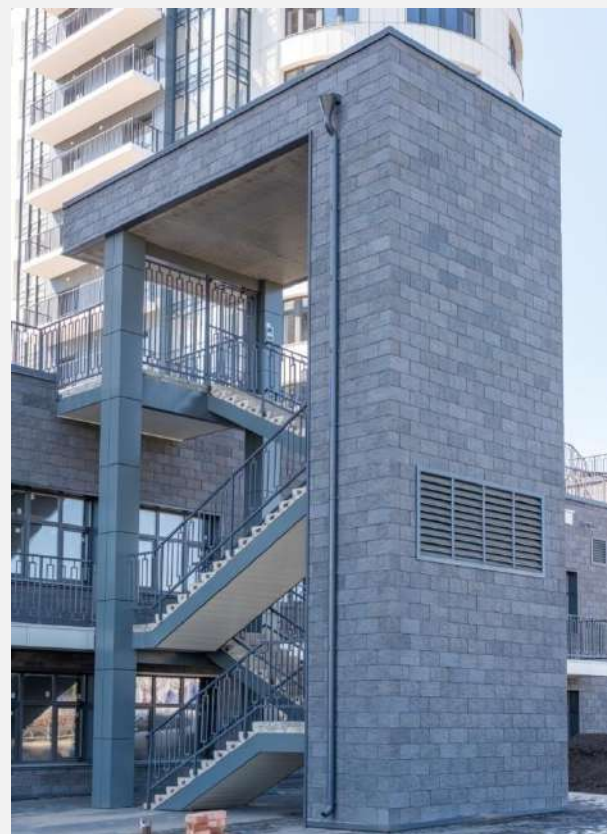
→ Жилой комплекс «Адмирал» Красноярск, ул. Ленина, д.20 Материал: КраспанБрикФорм, КраспанКомпозит-ST Подсистема: L-ВСт и U-ВСт Краспан Площадь фасада: 11 261 кв.м 2019
