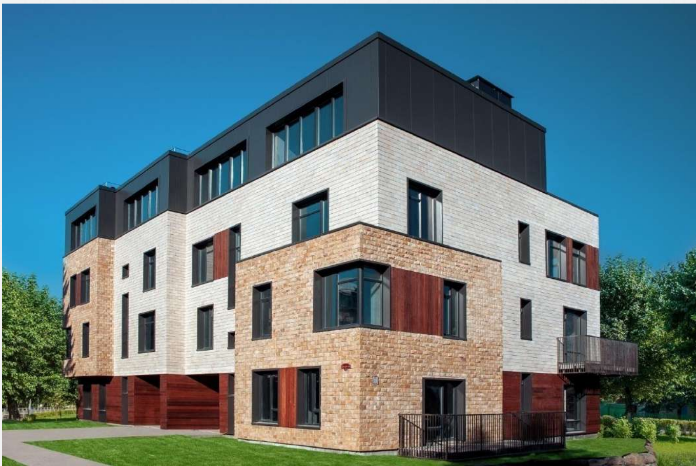
➔ ЖК «Снегири» Владивосток Материал: КраспанБрикФорм Подсистема: L-ВСтК Краспан Площадь фасада: 2500 кв.м 2019
