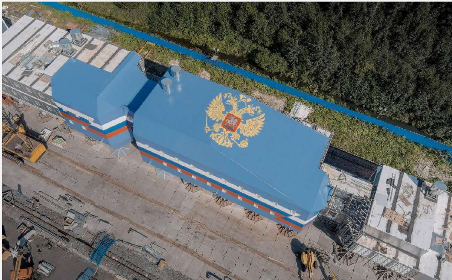
➔ Зимовочный комплекс Российской антарктической станции «Восток» Материал: КраспанКомпозит-AL Подсистема: L-BCт Краспан 2020
