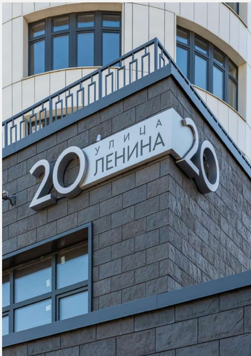
→ Жилой комплекс «Адмирал» Красноярск, ул. Ленина, д.20 Материал: КраспанБрикФорм, КраспанКомпозит-ST Подсистема: L-ВСт и U-ВСт Краспан Площадь фасада: 11 261 кв.м 2019
